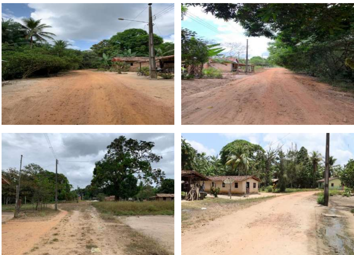
Figura 34. Estrada de acesso às comunidades do Chaú e Portinho.
