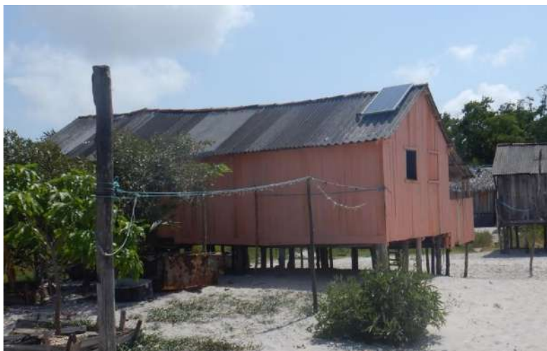
Figura 65. Instalação de placa solar na Ilha Canela.
